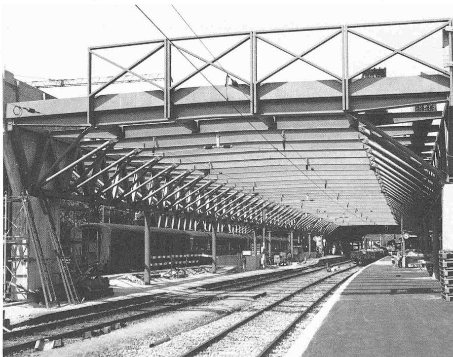
Bild 5. Überdeckung der Perronanlagen im Bau
