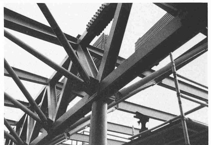
Bild 4. Räumliches Fachwerk als Tragkonstruktion
