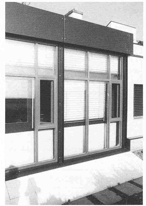
Bild 7. Die Chamäleonfassade weiss, auf Reflexion eingestellt
