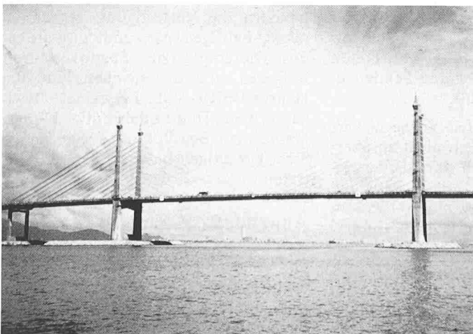
Bild 4. Ansicht der Penang-Brücke (Malaysia)
