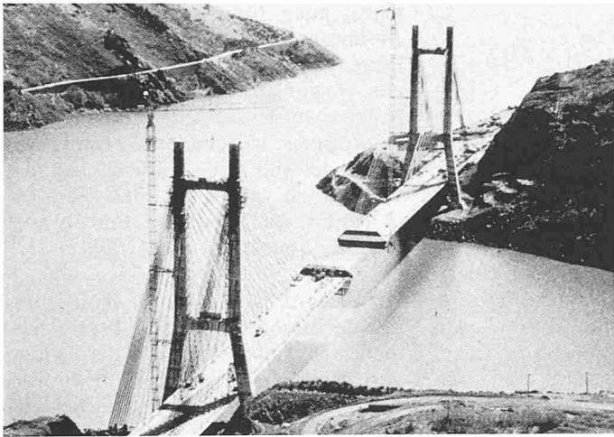
Bild 6. Ansicht der «Barrios de Luna»-Brücke (Spanien)
