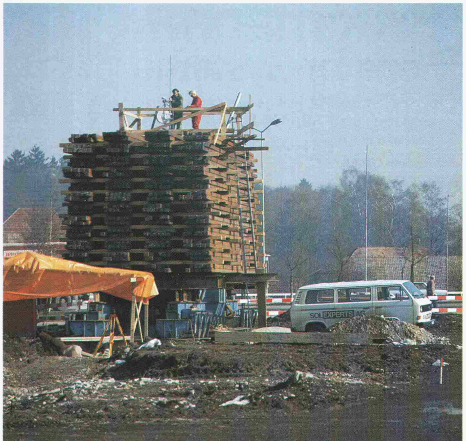
Pfahlbelastungsversuch Viadukt Neugut
