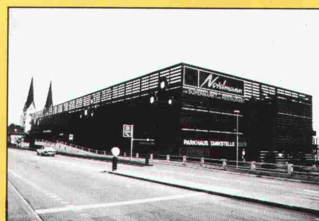
Mehrgeschossiges Parkhaus mit Zufahrt über Rampen
