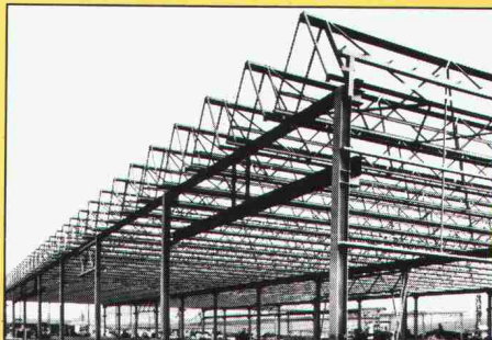
Metalstruktur eines Fabrikgebäudes mit Mini-Sheddach
