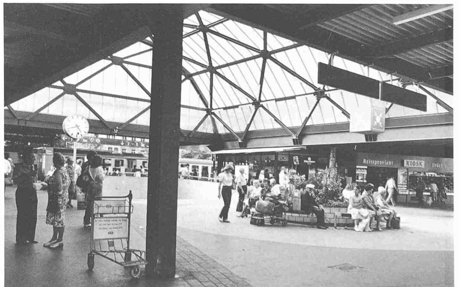
Die verglaste Gewölbekonstruktion des Bahnhofzuganges
