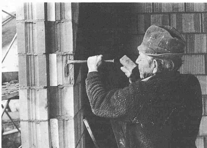
Bild 1. War der Fensterrahmen zu breit oder die Öffnung zu eng?
