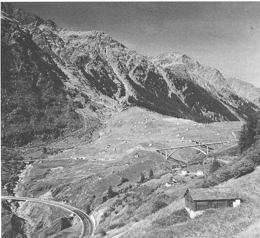
Bild 1. Mit dem Bau eleganter, den Formen des Geländes angepassten Brücken wurde es überhaupt erst möglich, in den steilen Talabfall des Miso (GR) die Nationalstrasse N 13 so zu bauen, dass sie heute die Landschaft kaum belastet
