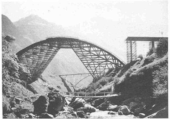
Bild 8. Lehrgerüst der Cascellabücke; im Hintergrund die Naninbrücke
