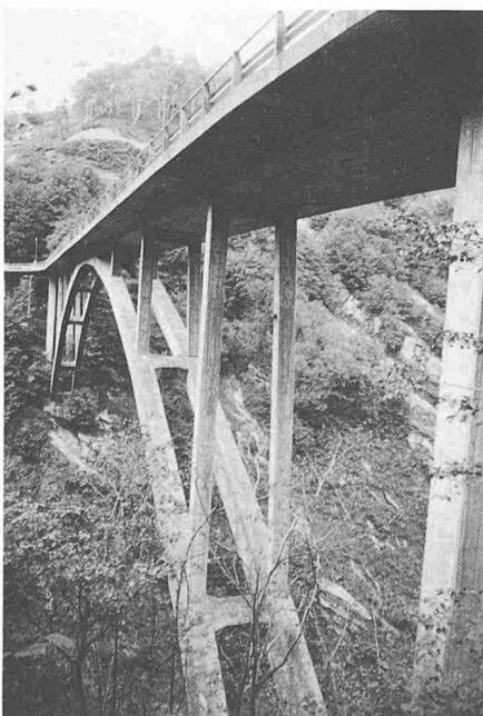
Bild 18. Calancascabrücke in der Schrägsicht
