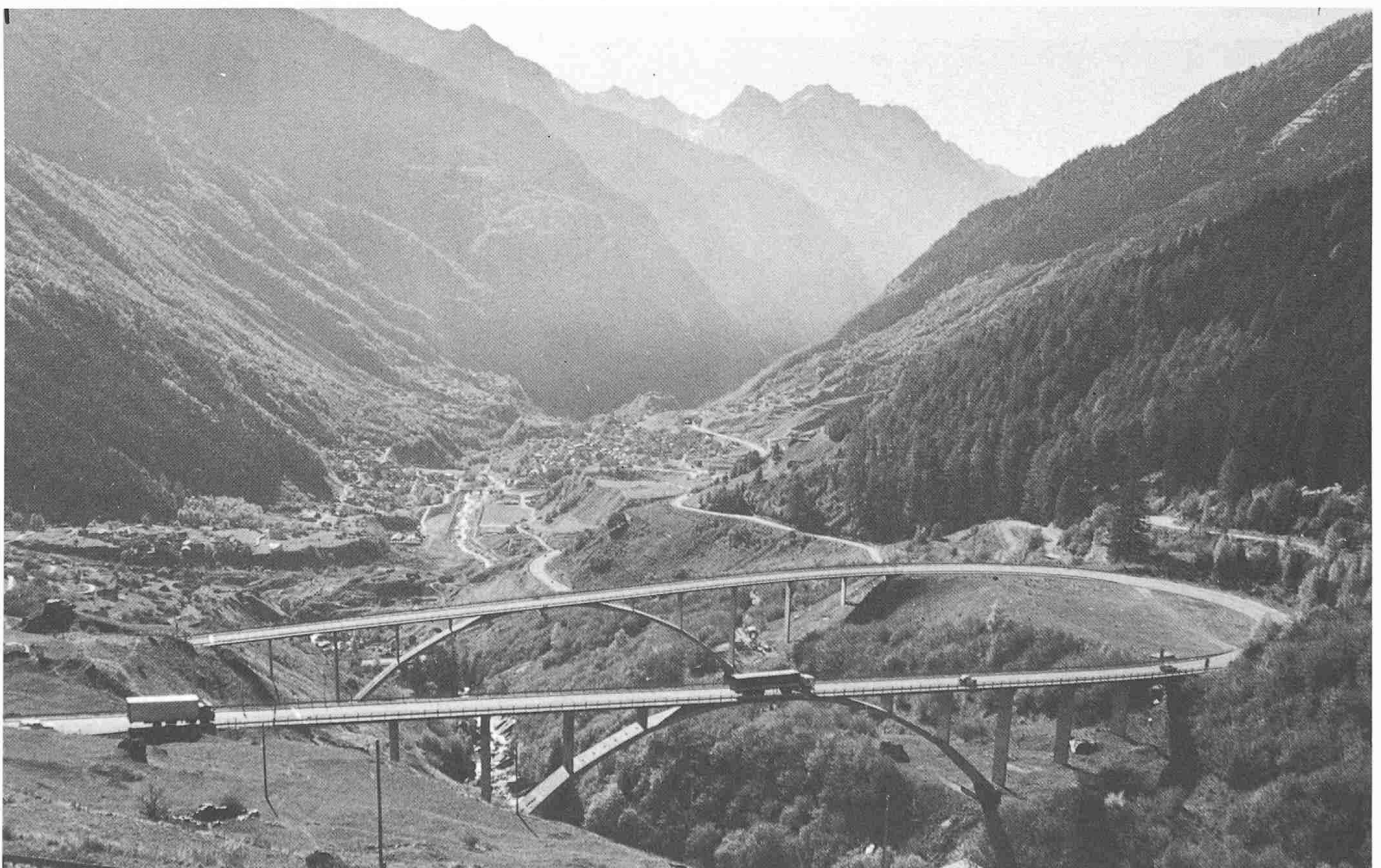
Bild 1. Cascella und Naninbrücke der N13 im Misox
