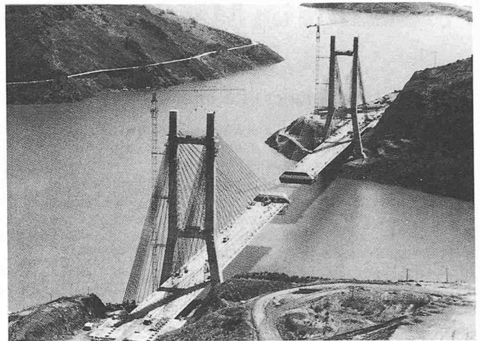
Bild 10. Schrägseilbrücke als Vielseilsystem
