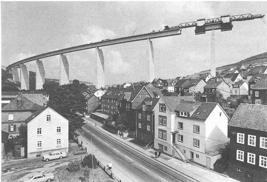
Bild 4. Abschnittweiser Vorschub der Brücke
