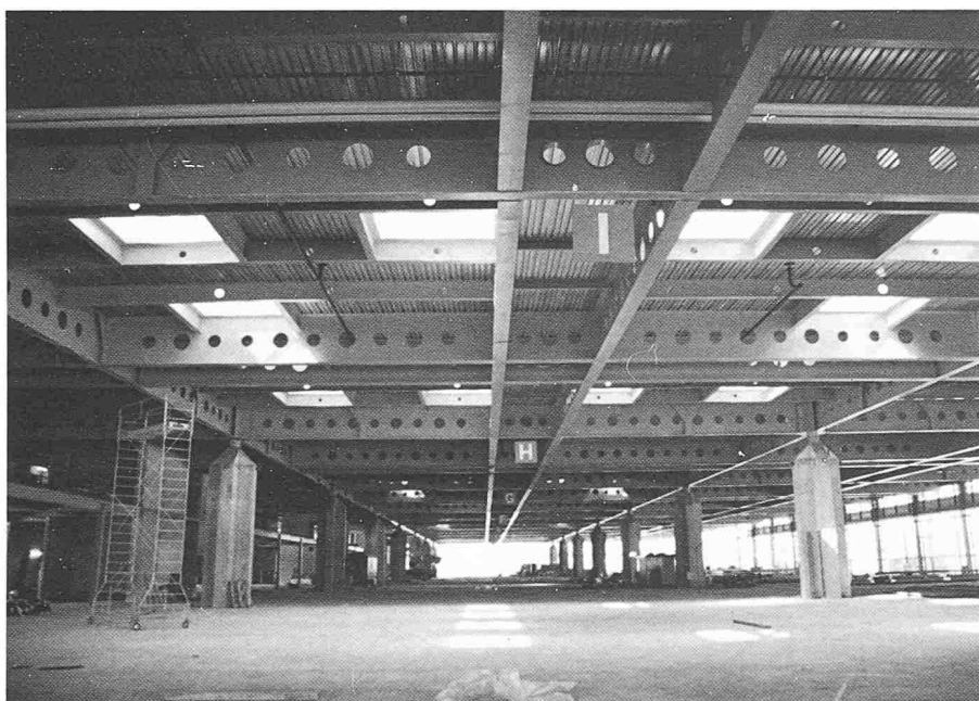
Photo B. Vue intérieure de la halle
