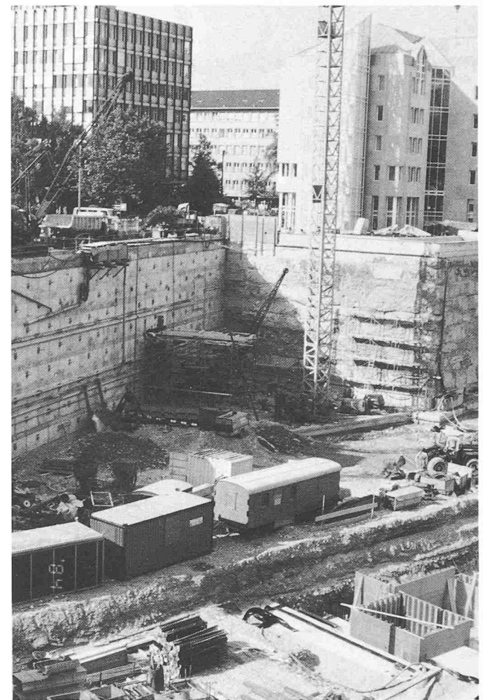
Bild 2. Blickrichtung anströmendes Grundwasser
