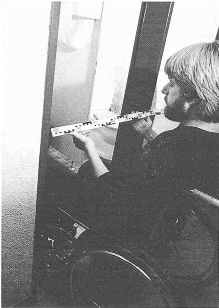
Bild 3. Genügend breite horizontale Durchgänge, keine Türen unter 80 cm
