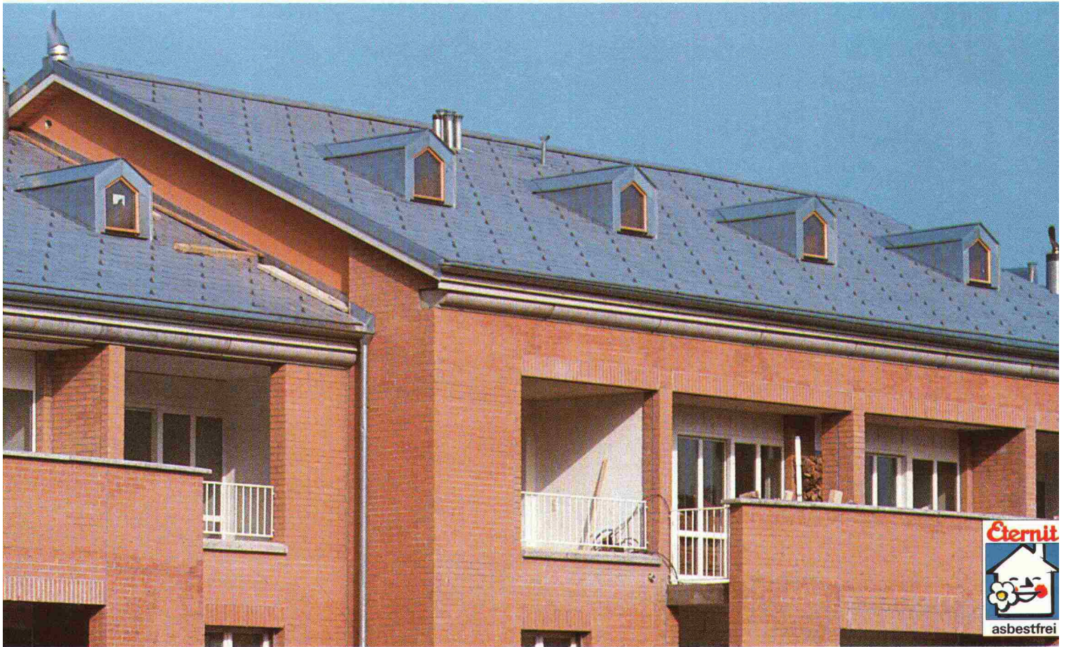
Mehrfamilienhaus «Habitat», 8957 Spreitenbach. Architekt Urs Fischbacher, Dachdecker P. Wiederkehr
