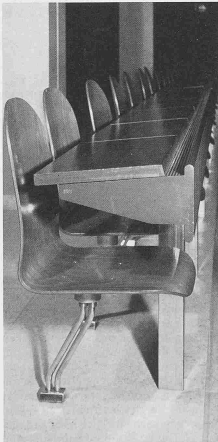
Bild 4. Pultkantenauslässe im grossen Hörsaal der Universität Zürich-Irchel (Werkfoto Sulzer)
