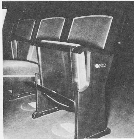
Bild 2. Zwei Varianten von Bodenauslässen: links Stadttheater Bern, rechts Stadttheater Winterthur (Werkfoto Sulzer)
