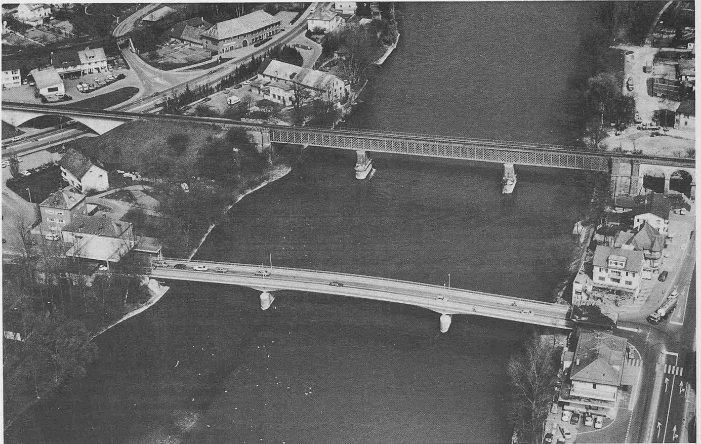
Rheinbrücken Koblenz-Waldshut, Zollbrücke und Eisenbahnbrücke
