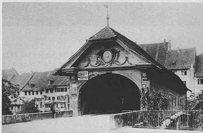
Reussbrücke Mellingen, Portal
