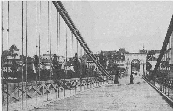
Aarebrücke Aarau, Kettenbrücke
