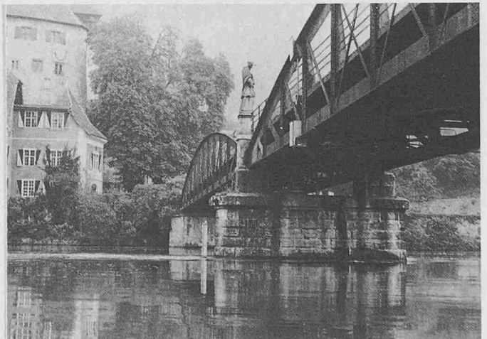
Neue Rheinbrücke Kaiserstuhl
