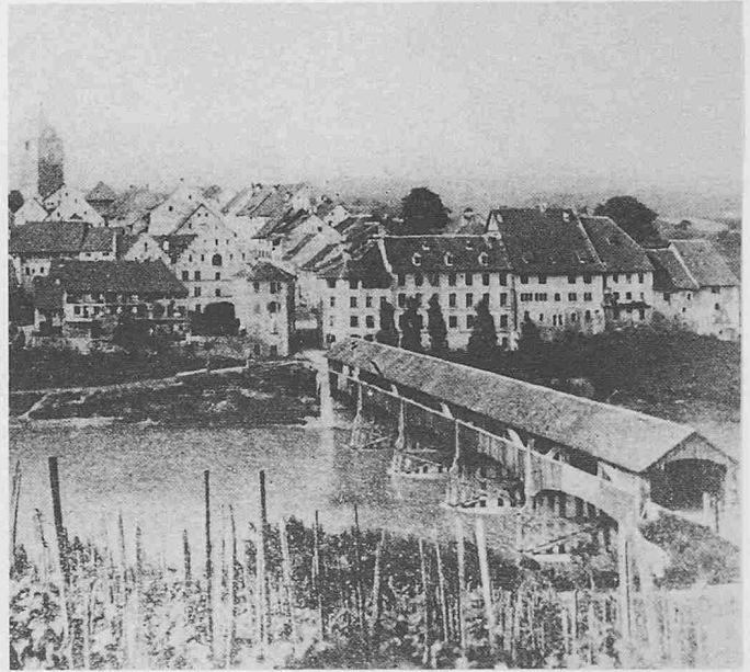
Rheinbrücke Kaiserstuhl, Holzbrücke
