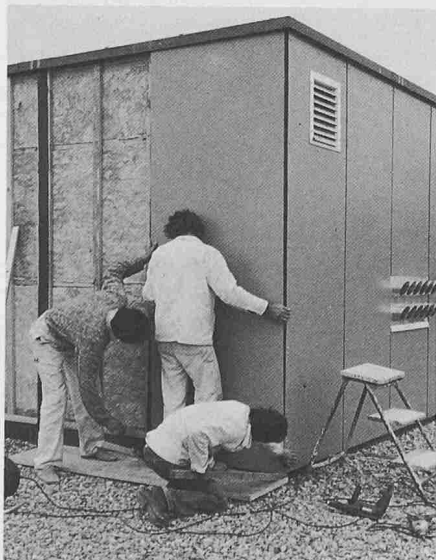
Montage der MEG-Fassadenplatten bei Liftaufbau
