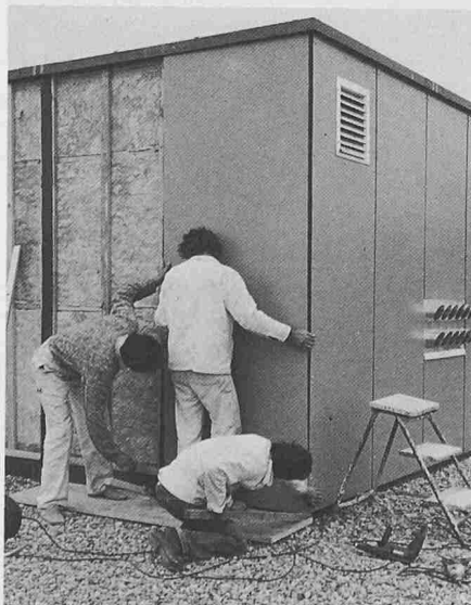
Montage der MEG-Fassadenplatten bei Liftaufbau
