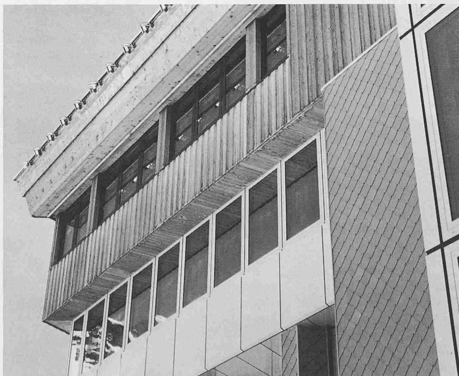
Fassadenausschnitt Ecke Südwest
