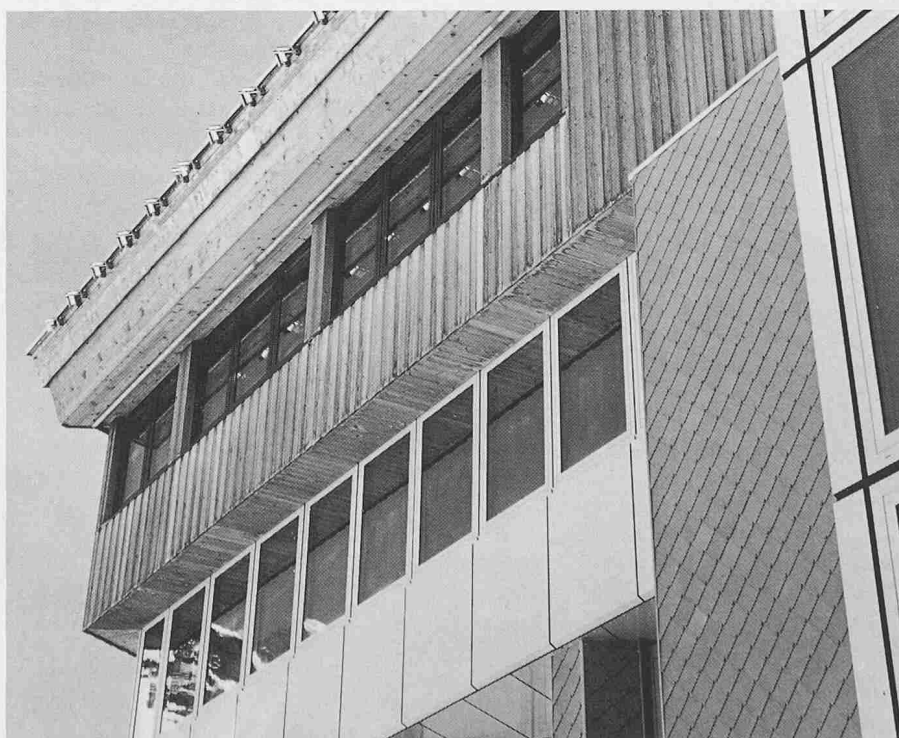
Fassadenausschnitt Ecke Südwest
