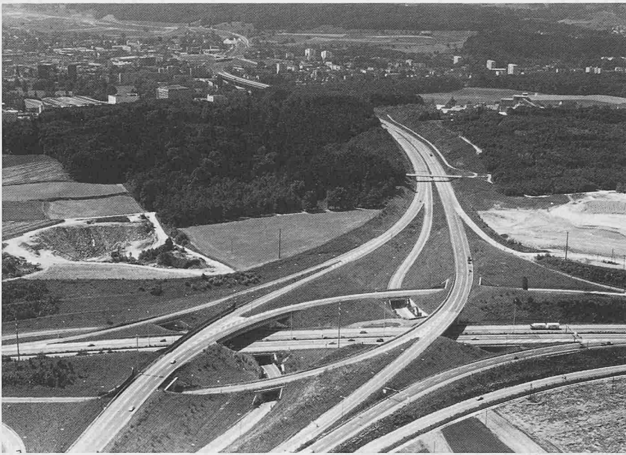
Vom Weiningerkreuz (im Vordergrund, mit der querlaufenden N1) führt das neue Teilstück der Zürcher Nordumfahrung zum Anschluss Urdorf (im Hintergrund links der Fahrbahnen Urdorf, rechts Dietikon). Danach verschwindet die Autobahn in einem Tunnel Richtung Bergermoos und Birmensdorf (Foto Comet)
