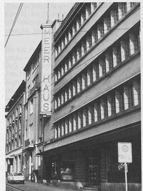
Meer-Haus, Bern Architekt: H. Weiss, 1929
