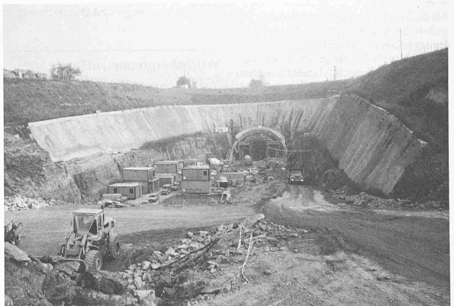
Bild 3. Voreinschnitt West des Rollenbergtunnel
