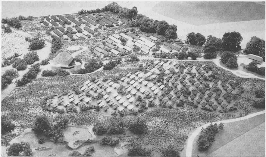
Die 50 000 m 2 Gelände umfassende 300-kW-Anlage Koborn-Gondorf im Modell: links vor dem Solarzellenfeld die Schaltzentrale, links unten Teiche des Biotops (Modellaufnahme RWE)(Quelle: SEV/VSE Bulletin 16/87)
