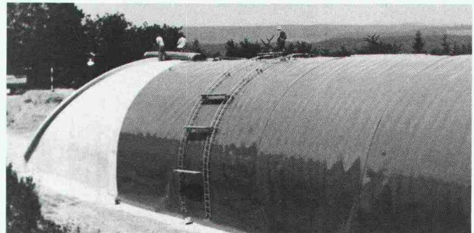
Tunnel «Nordumfahrung Zurzach» – zur Zeit in Ausführung: abgedichtet mit 30 000 m<sup>2</sup> Sarnafil Typ FP 4 mm.
