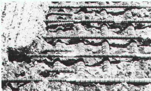
Damit entstehen optimale Voraussetzungen für die Rostschutzbehandlung der Armierung, für die Reprofilierung mit Spezialmörteln für den Oberflächenschutz zur Verhinderung von neuen Schäden.
