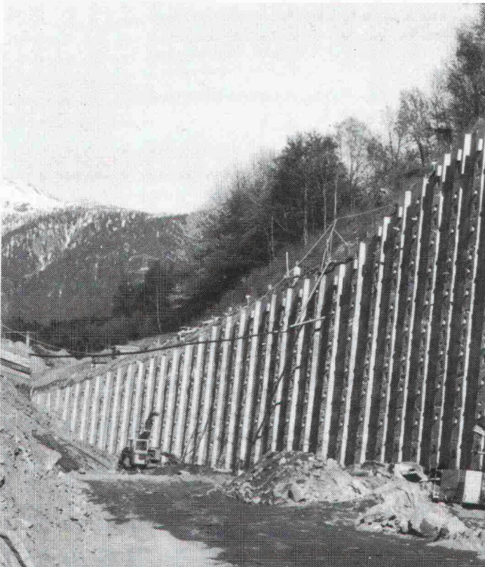
Stützmauern im Bereich des im Tagbau erstellten 215 m langen Gstipf-Tunnels
