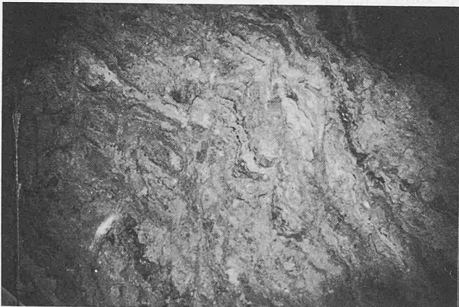
Bild 5. Rheingletschermoräne, sehr kompakt gelagert mit Abbauspuren
