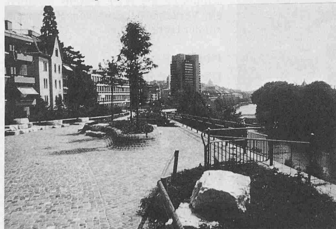
Bild 5. Überdeckung Südportal Milchbucktunnel. Rechts die Limmat
