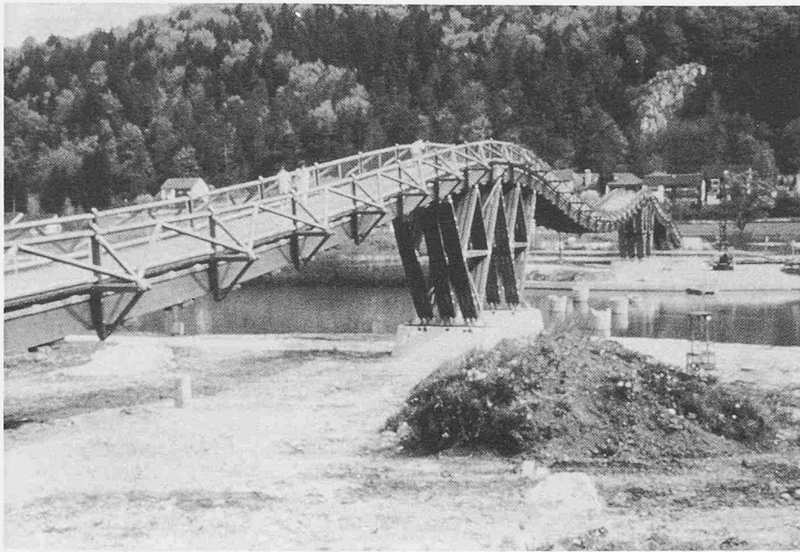
Bild 6. In einer flachen Wellenlinie, wie ein gespanntes, aber leicht durchhängendes Seil, führt die Fussgängerbrücke von Essing über den Main-Donau-Kanal
