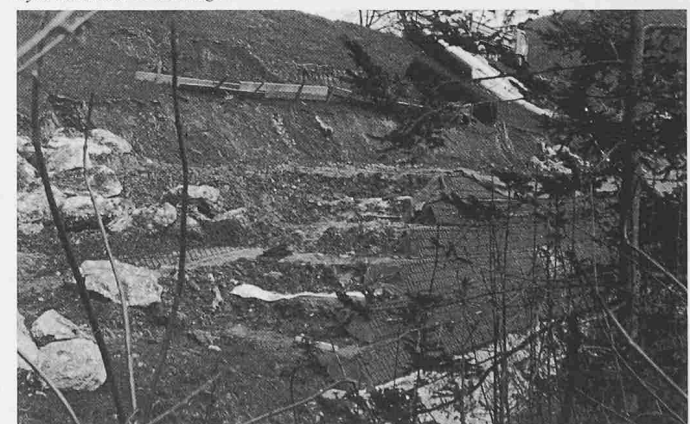
Bild 20. Gleiche Konstruktion etwa 4 Monate nach der Begrünung mit Spezialhydroaat und Buschlagen
