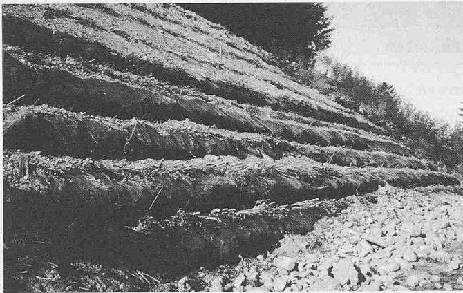
Bild 6. Rutschverbauung mit «Polsterwand», Begrünung mit Buschlagen
