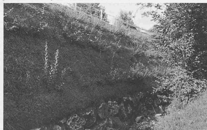
Bild 19. Geotextilarmierte Stützkonstruktion (System Textomur) mit Stützgitter als Einbauhilfe, Rohbauzustand
