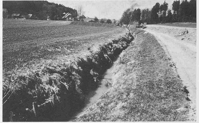
Bild 10. Durchgehende Strukturmatte, Sohle überschottet, Ufer mit Uferfaschine, Stekhölzern, Buschlagen
