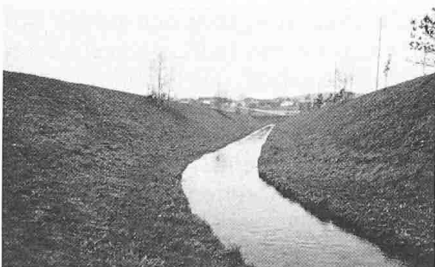
Bild 2. Revitalisierungsarbeiten am Nefbach, September 1986
