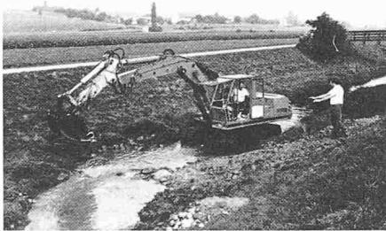
Bild 1. Oberlauf des Nefbachs (ZH), ausgeführt gemäss Projekt 1966
