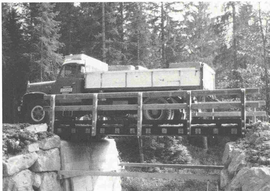
Bild 3. Brücke für Walderschliessungsstrassen
