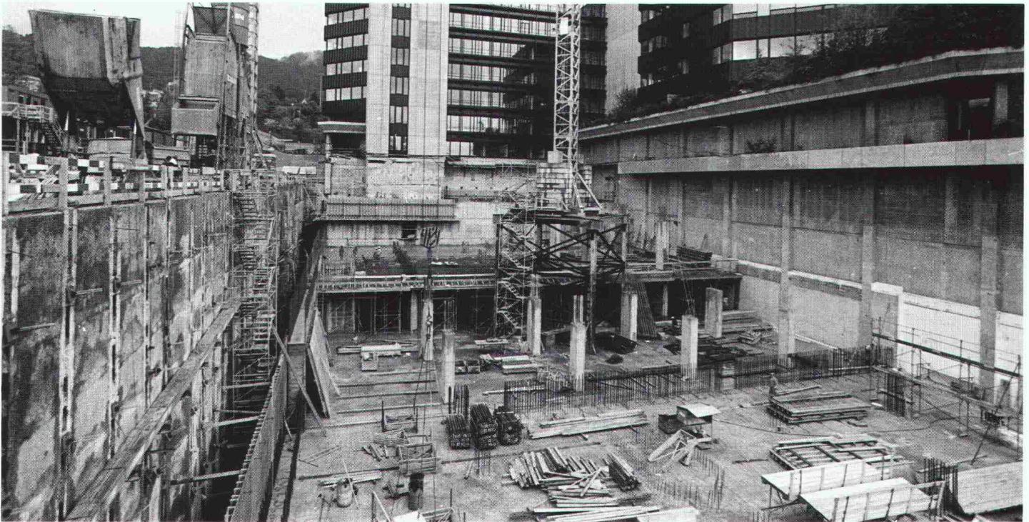
Es zeigt sich in der Praxis: langfristig erhaltender Bautenschutz erfordert meistens eine Kombination von Massnahmen schon von Anfang an: ■ Starre Renesco-Vandex-Flächenabdichtungen ■ Injektions-Abdichtungen von Fugen und undichten Stellen am Rohbau ■ Abdichtung von Rohrdurchführungen ■ Beschichtungen von Parkdecks, Tankräumen, Liftunterfahrten ■
