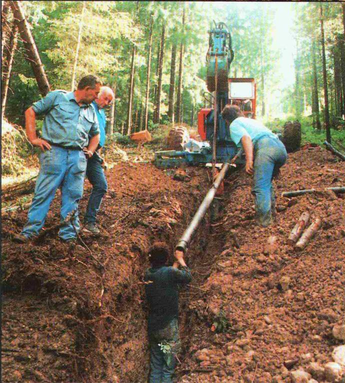
**R**ohrverlegung unter erschwerten Bedingungen im Steilhang. Deutlich erkennt man die problematischen Bodenverhältnisse. Dennoch konnte aufgrund des FZM-Panzers der Rohre auf den Kieskoffer verzichtet werden.
