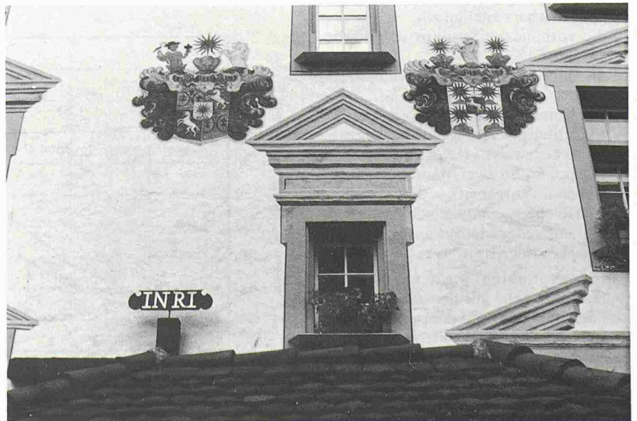
Bild 4. Vermutlich wurde hier der Grundputz mit der Kelle dressiert (geglättet). Haus zur Liebenau, Luzern
