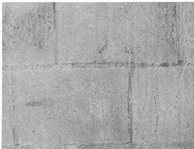
Bild 11. Dieser «Zementanwurf» gleicht eher einer Glasur. Die dünne, feinkörnige, mit zuviel Wasser angemachte Mörtelschicht «verdurstete» auf dem stark saugenden Backstein und konnte nicht voll erhärten
