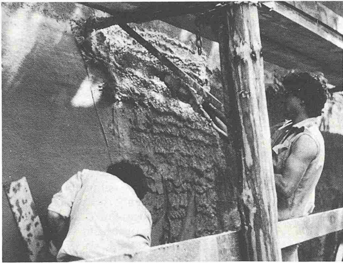
Bild 7. Renovation einer Fassade mit konventionellem HK-Grundputz mit Sand 0-4 mm. Dieser Mörtel wird gepumpt und mit der Spritzdüse aufgetragen. Durch das Verziehen mit der Latte entsteht eine Sinterhaut, die entfernt werden muss
