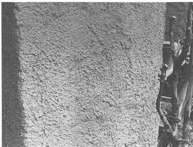
Bild 10. Ein vollflächig deckender Anwurf mit HK-Mörtel 0-8 mm. (Sandsteinpfeiler einer Kirche.)
