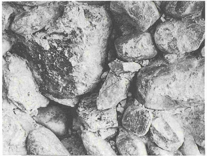
Bild 9. Das Stopfen einer solchen freigelegten Mauerpartie verlangt Geschick und Sorgfalt des Maurers. (Schloss Laupen, Südbau 1986)
