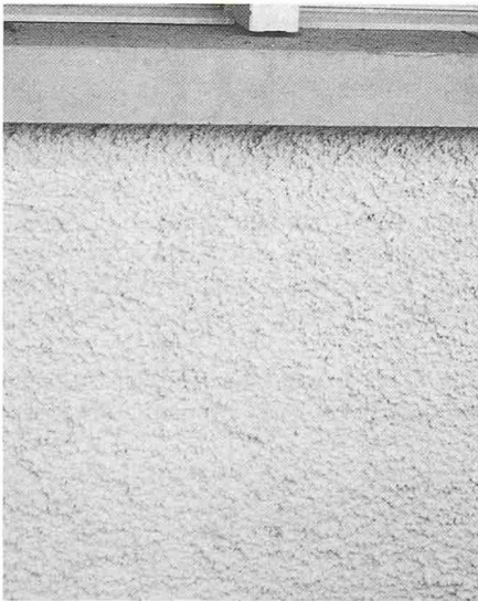
Bild 16. Kellenwurf als Deckputz. (Lindenplatz, Pfungen)
