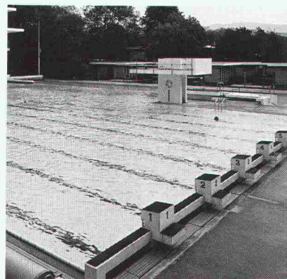
Basel Sportbad St. Jakob: Wasserverluste durch undichte Fugen verlangen eine sofortige Sanierung. Gezielte Injektionen machen das Bassin wieder dicht.
