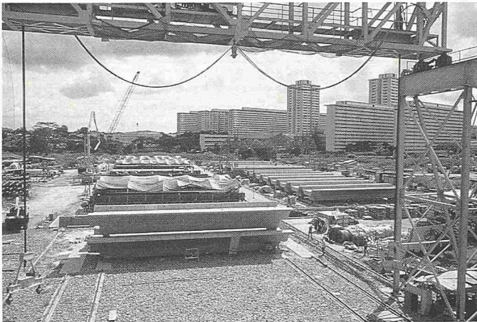
Bild 2. Los 203. Gesamtansicht der Vorfabrikationsanlage. Links Vorfabrikationsstrasse, rechts Lager
