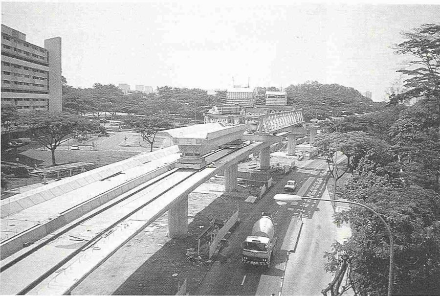
Bild 4. Transport auf dem Viadukt
