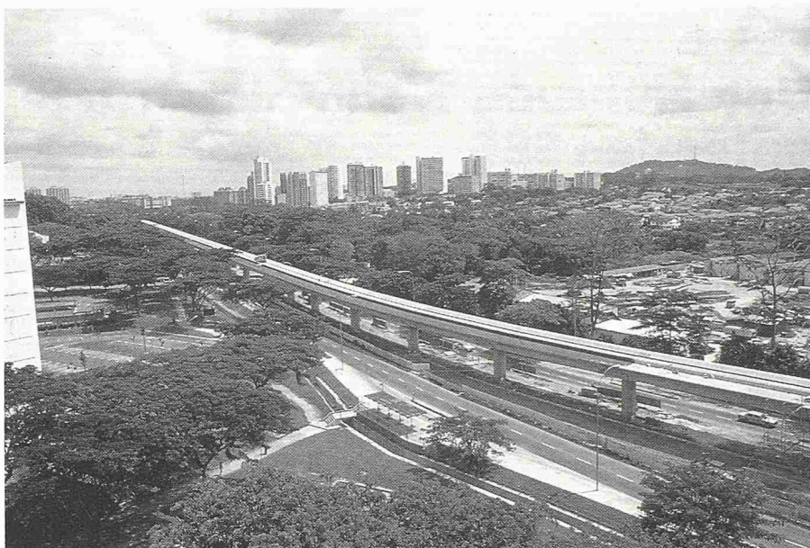
Bild 6. Fertig erstellter Viaduktabschnitt im Los 203
