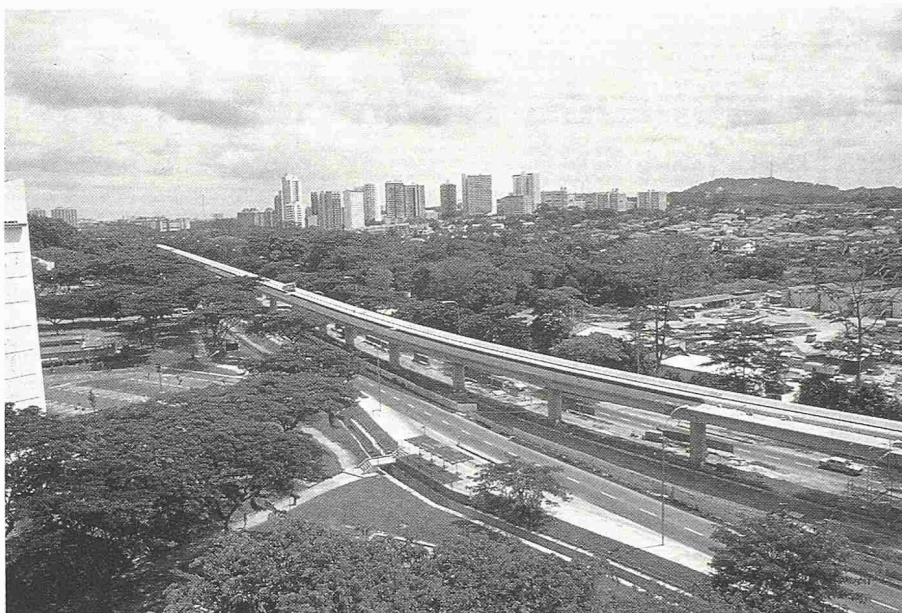
Bild 6. Fertig erstellter Viaduktabschnitt im Los 203
