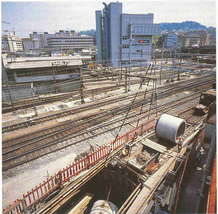
Bild 6. Kabelstollen. Blick vom Pressschacht Richtung Zentralstellwerk. Wellpointinstallationen im Bereich der Weichen.
