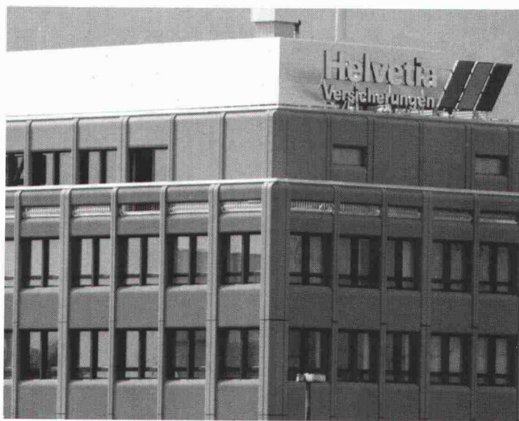
Geschäftshaus Helvetia-Unfall Zürich
