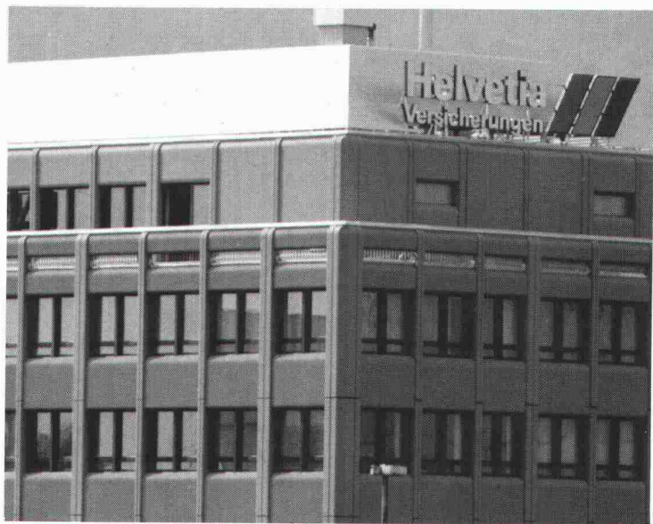
Geschäftshaus Helvetia-Unfall Zürich
