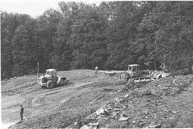
Bild 5. Schütтарbeiten in einer Wendeplatte
