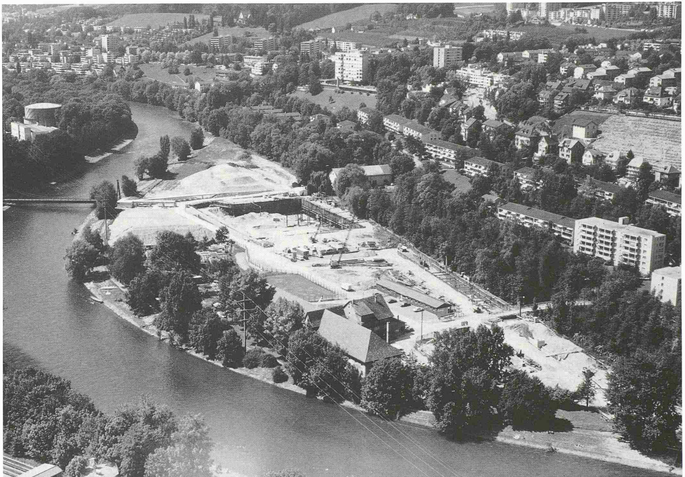
Bild 1. Zulaufkanal und Regenbecken im Bauzustand Sommer 1986
