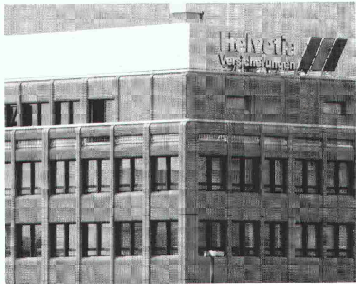
Geschäftshaus Helvetia-Unfall Zürich
