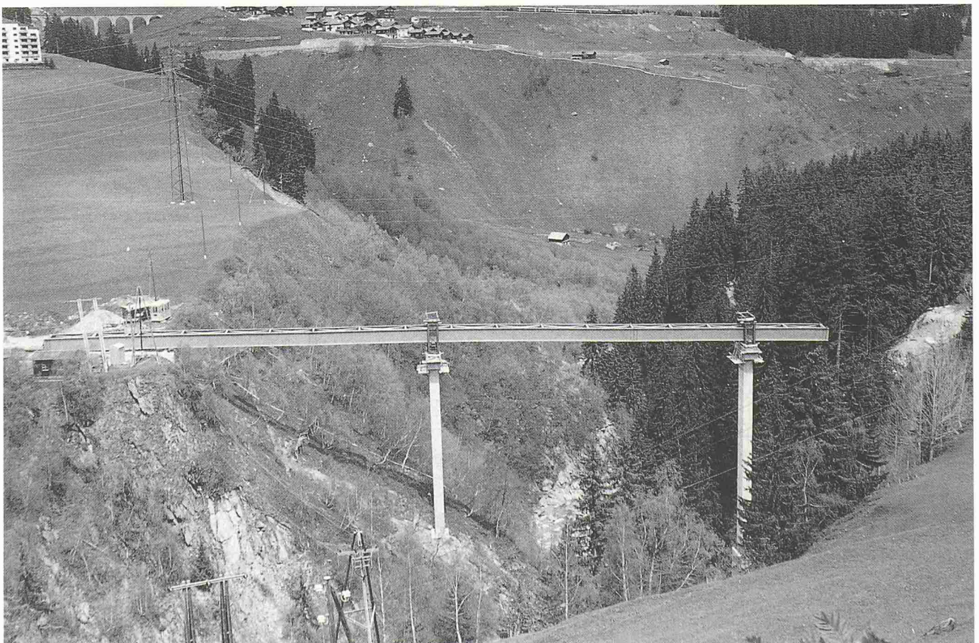
Bild 1. Ansicht der Baustelle
