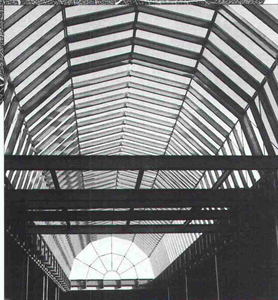
Stahl- und Industriebau
