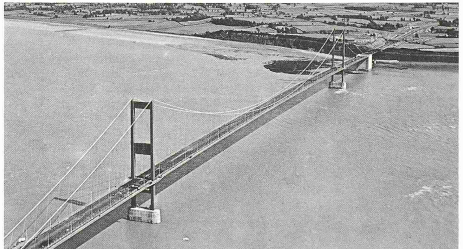
Brücke über die Severn-Mündung, Spannweite 1080 m, 1966
