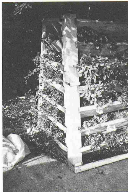
Bild 5. Bepflanzte Lärmschutzwand aus druckimprägnierter Buche. Buchenholz erreicht annähernd die Festigkeitswerte wie das früher für dieses System oft verwendete Tropenholz Bongossi
