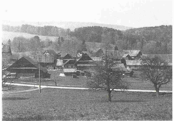
Beispiel Weiler (Winterschwil): Ein Ortsbild ohne schützenswerte Einzelbauten, aber von nationaler Bedeutung, weil eine enge Beziehung zwischen den Höfen mit den mächtigen Ziegeldächern und der umgebenden Landschaft besteht. Die Ortsränder sind unverbaut und die Vorgärten und -plätze mehrheitlich intakt
