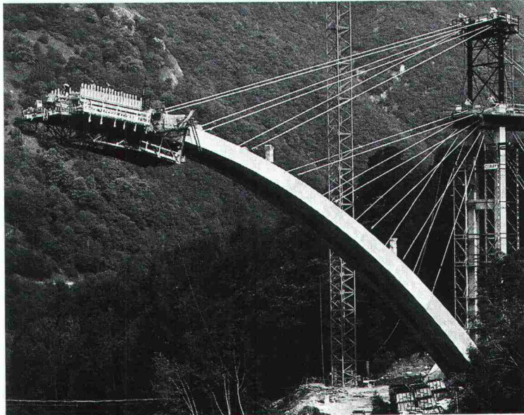
Bau der Ponte Soi-Brücke, Lukmanier-Route.
