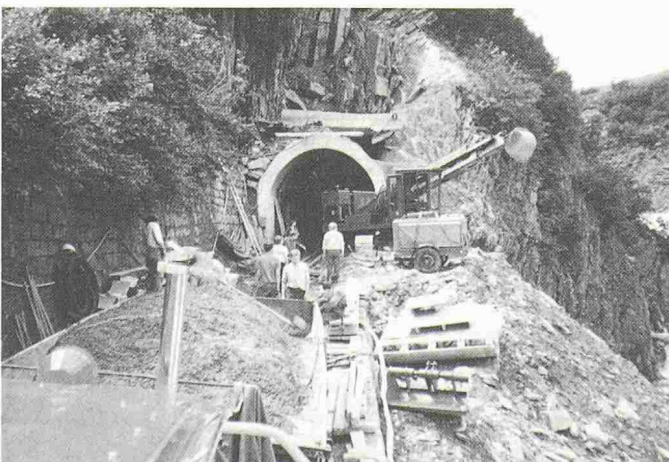
Alt-Senntum-Stafeltunnel III: Grosseinsatz (Bild: Archiv DFB)
