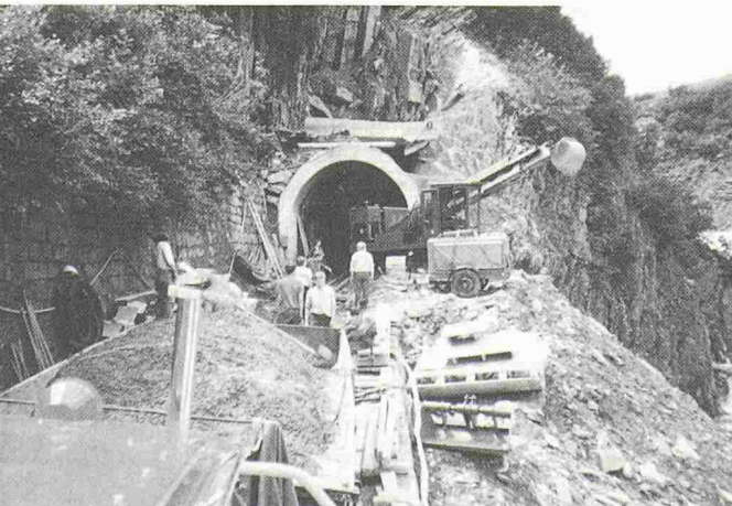
Alt-Senntum-Stafeltunnel III: Grosseinsatz (Bild: Archiv DFB)
