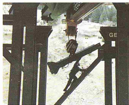
Bild 9. Montage der Querverstrebungen Bildautor: A. von Glutz
