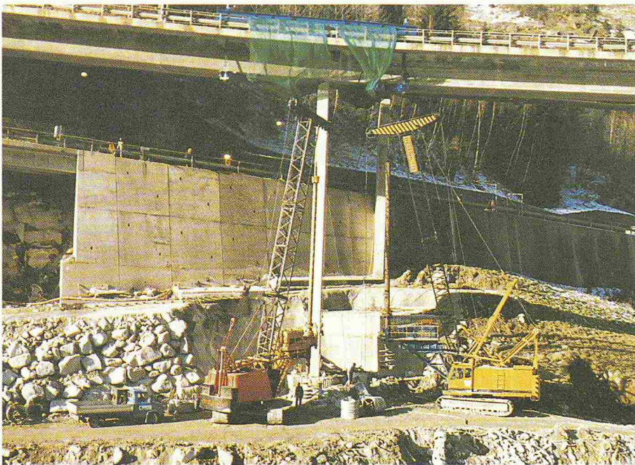
Bild 5. 2 Bohrgeräte beim Pfählen (A. von Glutz)
