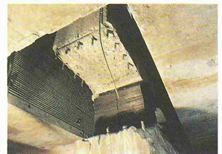
Bild 18. Notstapel zwischen Pfeiler und Pfeilerstummel (L. Buscarlet)
